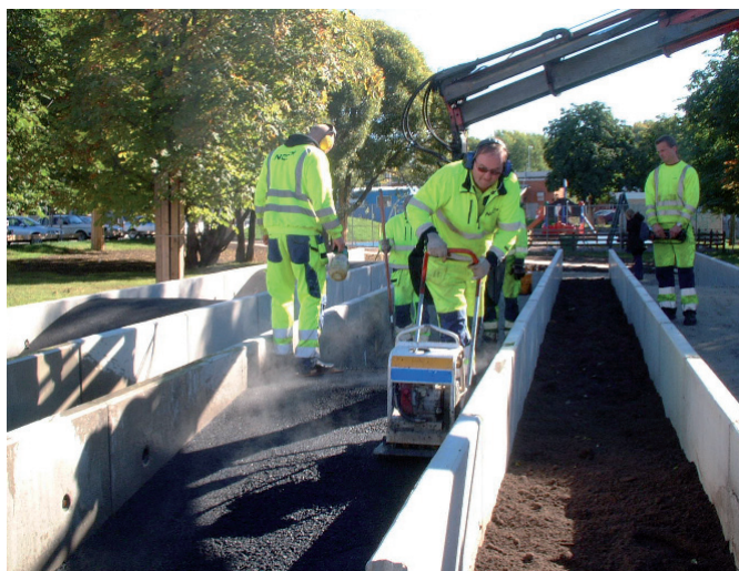
Anläggningsarbete i Midgårdsparken, asfaltering av multirullbana
